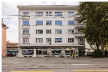
Birmensdorferstrasse 285 Zürich-Wiedikon, 15 Wohnungen
