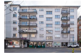
Birmensdorferstrasse 191 Zürich-Wiedikon, 16 Wohnungen
