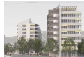
Hofwiesenstrasse Zürich-Unterstrass, 111 Wohnungen
