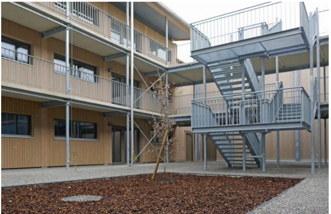
Die Siedlung überzeugt durch ihre ökologisch vorbildliche Holzmodulbauweise.
